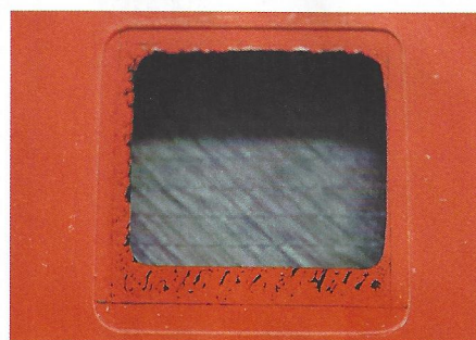
Auch hier (Querruder-Servoschacht) müsste eigentlich alles Schraffierte weg, um einen Servorahmen einbauen zu können, ...
